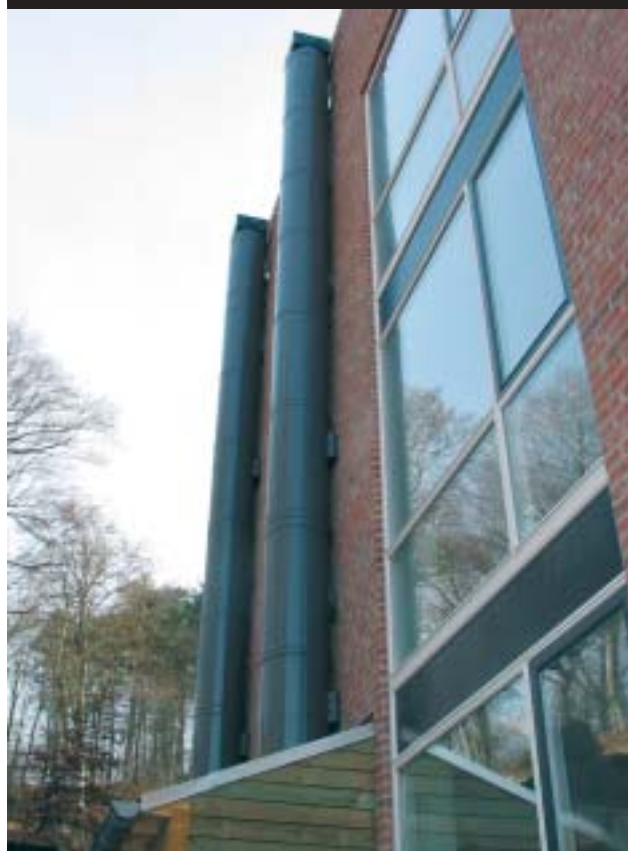
Skakt i opgang Skovbrynet, Frederiksværk
