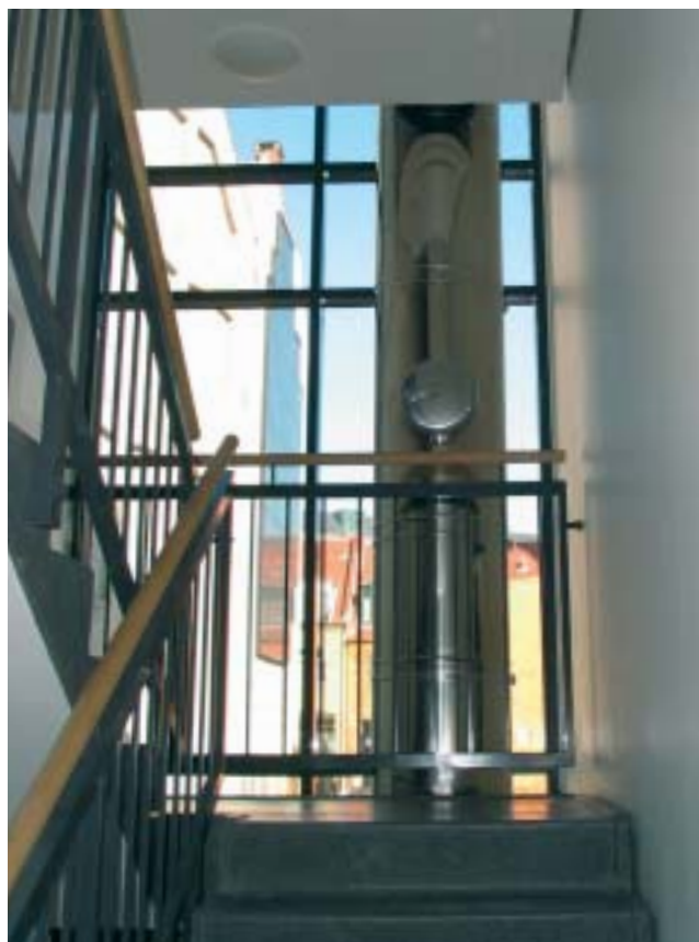
Skakt i opgang Gasværksvej i København
