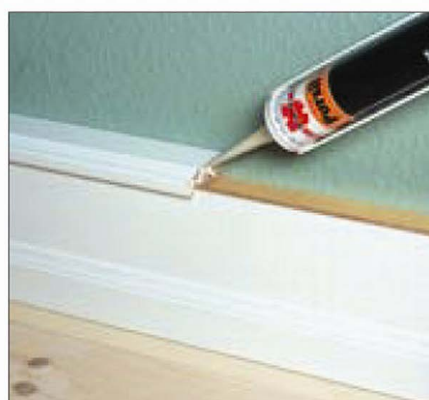
24. Alle samlinger, undtagen not , samles med Fugemasse MS 20. (Kan leveres af Kierulff as).
