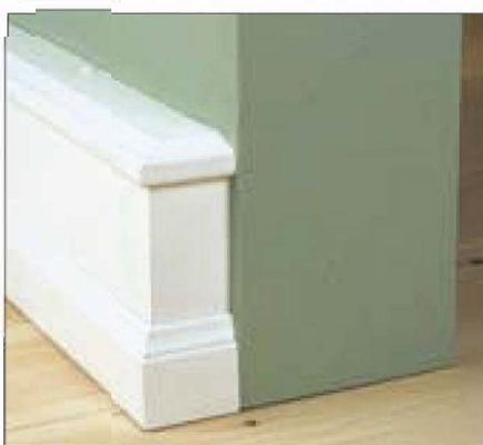
23. Afslutning af panel ved åben væg/dør. Enderne samles med Fugemasse MS 20.
