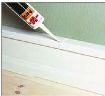
25. Alle samlinger efterfuges med Fugemasse MS 20. Overskydende fugemasse fjernes med en japanspartel og tørres efter med en fugtig klud.
