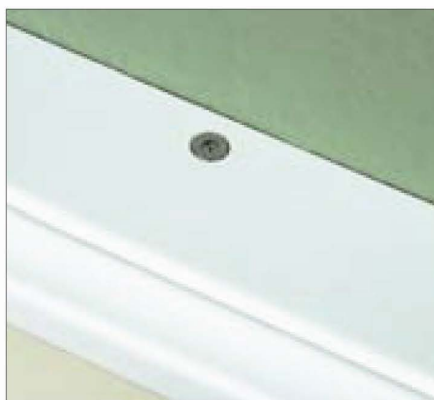
17. Topprofilet skrues fast på støttestellen, så skruen er helt plan med topprofilet.
