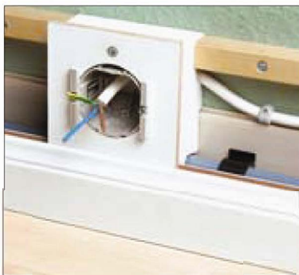
20. Varmebestandigt kabel føres i panelet og fastgøres med kabelclips på væggen. (Elarbejdet må kun udføres af aut. elinstallatør).
