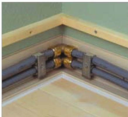
10. Ved indvendigt hjørne skal Gabotherm bagpanelet skæres i smig. Husk! der skal anvendes Gabotherm vinkler til Gabothermrør.
