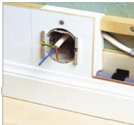
21. Frontpanelet stødes op til stikkontaktmodulet og samles med Fugemasse MS 20.
