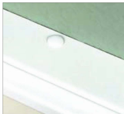
18. Dækhætten trykkes fast i skruenhovedet.
