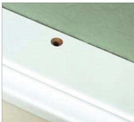
16. Ved fastgørelse af topprofilet på støttestellen bores et 4 mm hul 10 mm fra bagkant. Hullet udfræses med en undersænker, type 90° HSS Ø 8,3. (Kan leveres af Kierulff as).
