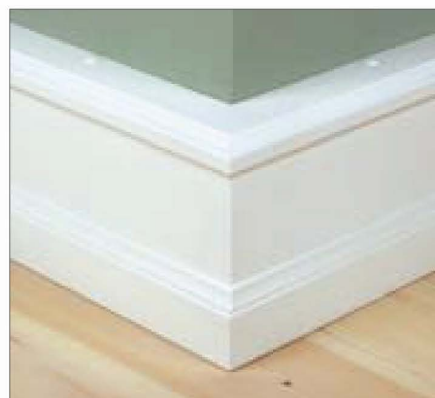
15. Færdigt udvendigt hjørne. Enderne samles med Fugemasse MS 20.
