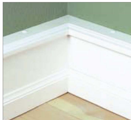
12. Færdigt indvendigt hjørne. Enderne samles med Fugemasse MS 20.
